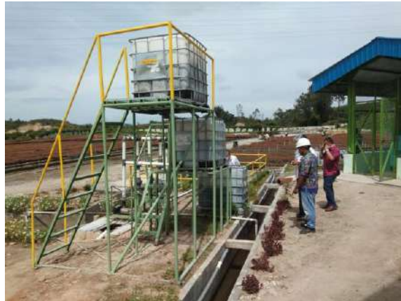
Gambar II-11. Sistem Penyaringan Buangan Air pada IPAL Nursery
