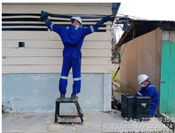
Gambar II-15. Pengujian Emisi Genset
