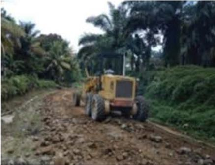
Perbaikan jalan menggunakan alat berat (grader dan bomag)
