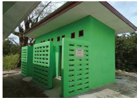
Pembangunan toilet SD Parlombuan Desa Tapan Nauli III Kecamatan Sipahutar
