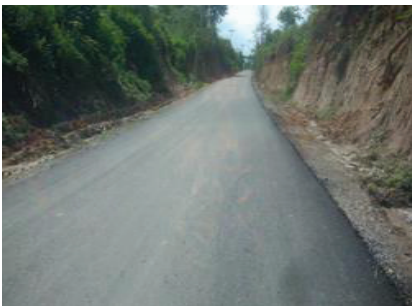
Pembangunan Jalan Pasar Sirongit-Lancang Sianipar Desa Pardomuan Kecamatan Laguboti
