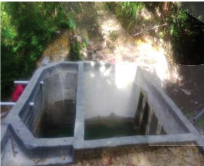
Pembangunan bendungan & pisanisasi Desa Janji Maria Kecamatan Borbor
