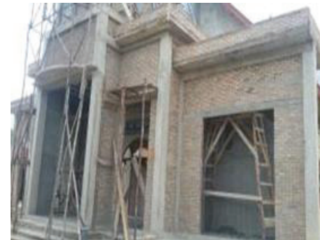
Pengadaan material pembangunan HKBP Simanungkalit Desa Simanungkalit Kecamatan Sipoholon
