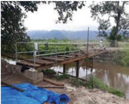
Perbaikan jembatan Desa Lumban Manurung Kecamatan Parmaksian
