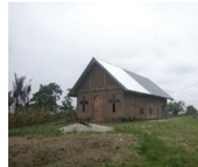
Pengadaan material pembangunan HKBP Maranatha Sirube-rube Desa Gunung Purba Kecamatan Dolok Pardamean
