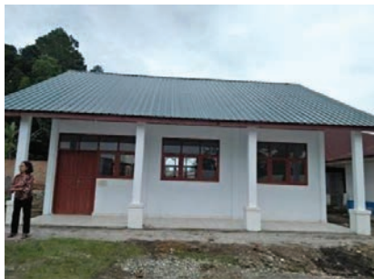
Pembangunan laboratorium komputer SMP N 1 Pollung Kecamatan Pollung
