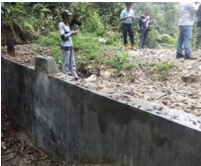
Pembangunan Tembok Penahan Tanah Dusun Huta Tonga Desa Pondok Buluh Kecamatan Dolok Panribuan
