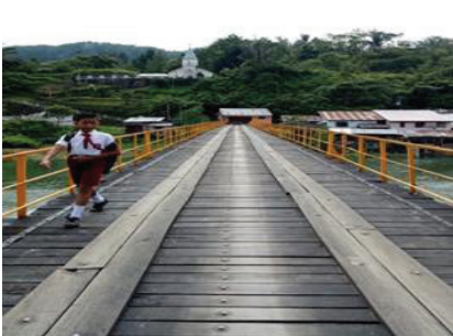
Perbaikan Jembatan Penyeberangan Desa Siruar Desa Siantar Utara Kecamatan Parmaksian
