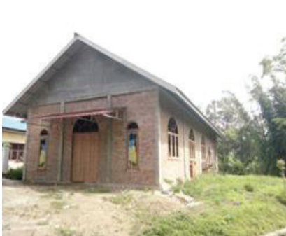
Pengadaan bahan material pembangunan HKBP Jorlang Nagori Jorlang Desa Jorlang Hulu Kecamatan Pematang Sidamanik
