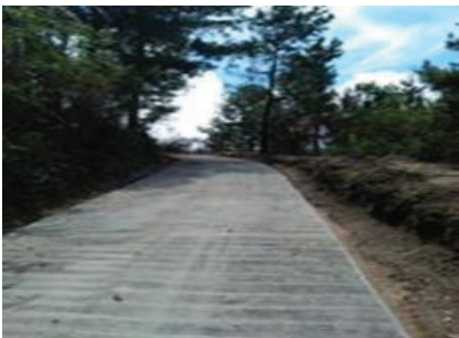
Pembangunan rabat beton Sosor Tao, Siruar Desa Siruar Kecamatan Parmaksian
