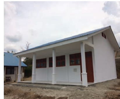
Pembangunan Ruang Lab. Komputer SMPN 1 Parmaksian Desa Jonggi Manulus Kecamatan Parmaksian
