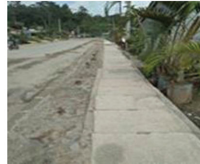
Pembangunan drainase Desa Tangga Batu I Kecamatan Parmaksian
