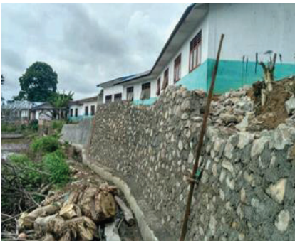
Pembangunan Dinding Penahan Tanah SD Negeri 173643 Desa Pangombusan Kecamatan Parmaksian
