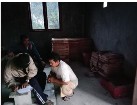
Pengadaan material pembangunan GPI Parlombuan Desa Parlombuan Kecamatan Sipahutar
