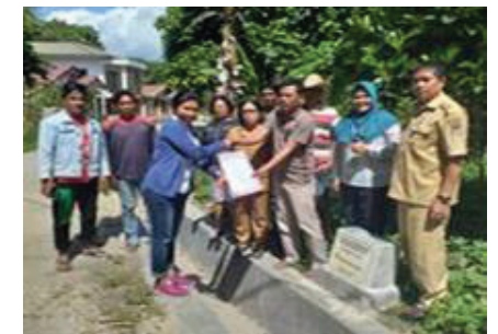
Pembangunan saluran irigasi & plat deker Desa Jonggi Manulus Kecamatan Parmaksian
