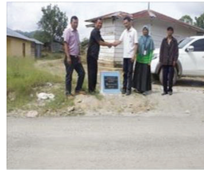
Pengaspalan Jalan Pondok Pabrik Desa Hitetano Desa Hitetano Kecamatan Habinsaran
