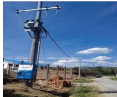
Pemasangan jaringan listrik ke SMP N-1 & SMA N 1 Parmaksian Desa Jonggi Manulus Kecamatan Parmaksian
