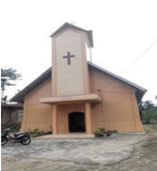
Pengadaan material pembangunan HKBP Marihat Raja Desa Marihat Marsada
