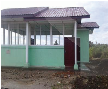
Pembangunan gedung PAUD Desa Parbuluan IV Dairi
