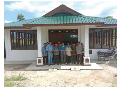
Pembangunan balai pertemuan Parlilitan Desa Sihas Dolok II Kecamatan Parlilitan
