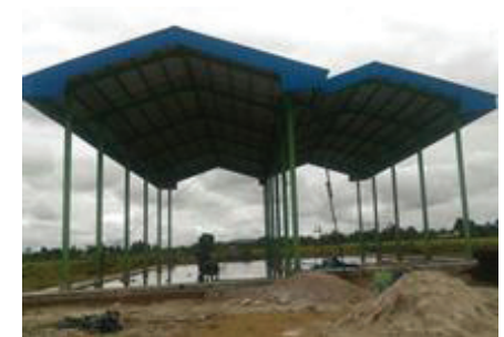
Pembangunan cold storage Desa Sigumpar Kecamatan Lintong Nihuta
