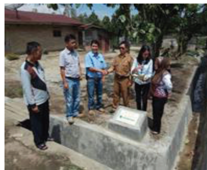
Pembangunan saluran drainase Dusun Manik Huluan Desa Sait Buttu Kecamatan Pematang Sidamanik
