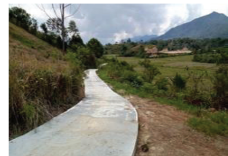
Pembangunan jalan rabat beton Banjar Ganjang Desa Banjar Ganjang Kecamatan Parmaksian
