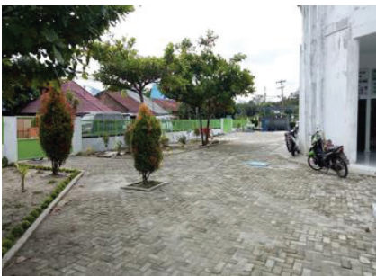
Pemasangan paving block dan pagar Puskesmas Porsea Program Tingkat Kecamatan Porsea
