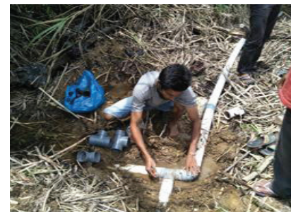
Bendungan & pipanisasi Desa Simataniari Kecamatan Palilitan
