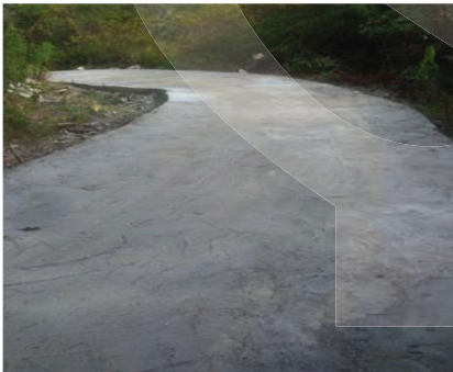
Pembangunan Jalan Rabat Beton Sepanjang 250 M. Desa Natumingka Kecamatan Borbor
