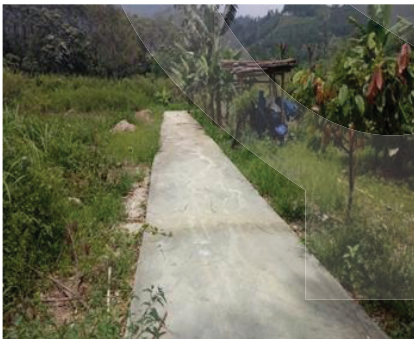
Pembangunan jalan pertanian dan wakaf Lumban Manurung Desa Tangga Batu I Kecamatan Parmaksian
