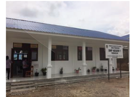
Pembangunan Ruang Kelas SMP N 1 Parmaksian Desa Jonggi Manulus Kecamatan Parmaksian
