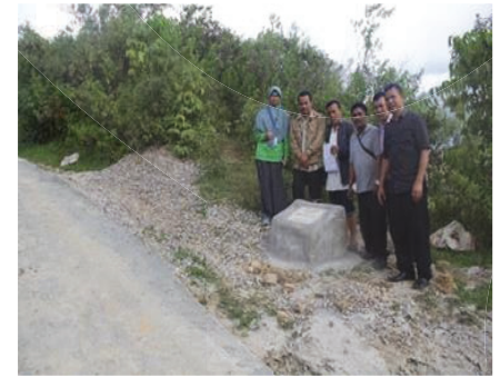
Pengecoran Badan Jalan Di Desa Sibide Barat Kecamatan Silaen
