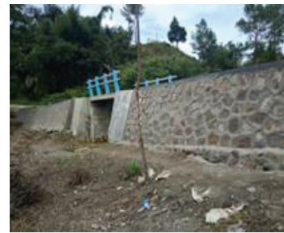
Pembangunan dinding penahan tanah Dusun Paras Desa Sipangan Bolon Kecamatan Girsang Sipangan Bolon
