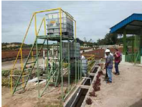
Gambar II-11. Sistem Penyaringan Buangan Air pada IPAL Nursery
