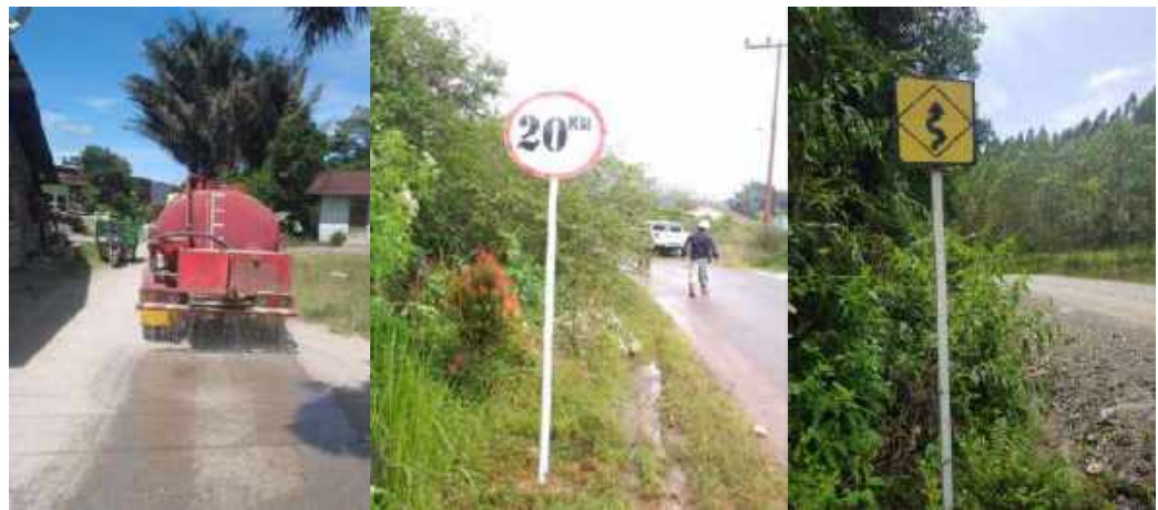
Gambar II-24. Penyiraman Jalan dan Rambu-Rambu Jalan
